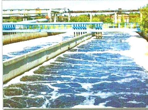
บ่อบำบัดน้ำเสีย
